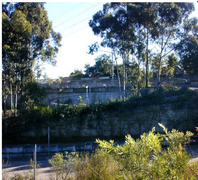
Chemins et tunnel pour piétons cycles sous un rond point.
