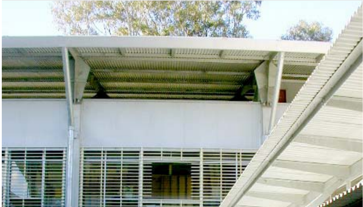
Exemple: le bâtiment de l'école d'infirmière: double toit et stores à lame.
